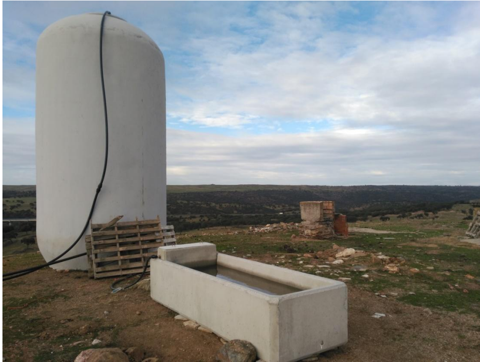
Instalación de depósito y bebedero en la finca Vando (Casar de Cáceres).
